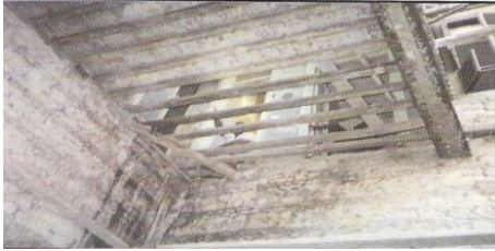
صورة ( 4 ) استبدال بعض العروق خلال الترميم لارضية الدور الأول ببيت الست عواطف.
