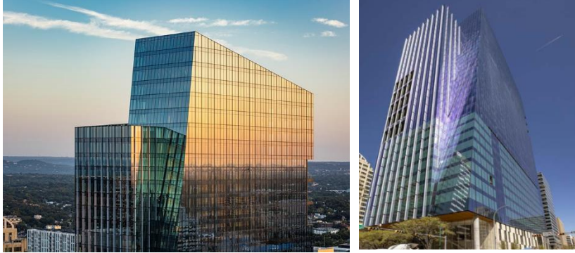
الشكل (17) قوائم الزجاج الرأسية بالواجهة الجنوبية للمبنى المصدر:
